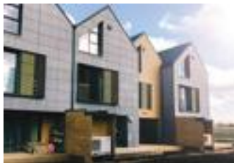
77 3-nadstropnih nizkoenergijskih hiš v Vilni (Latvija)
